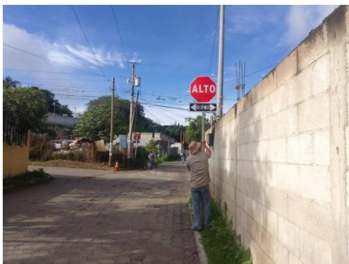
Fotografía 1: Instalación de señal vertical (alto doble vía).
