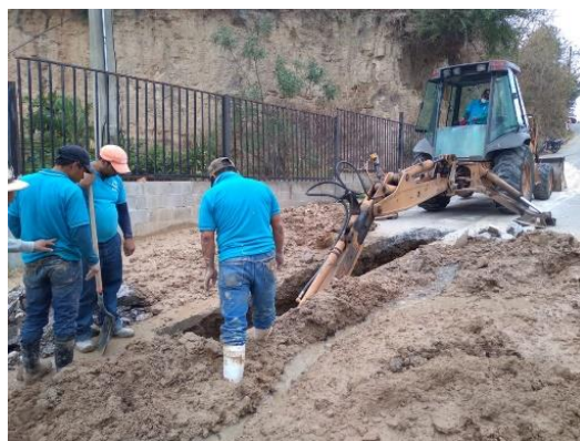
Fotografía 4: Reparación servicio de alcantarillado sanitario en tubería central Barrio la Estancia.
