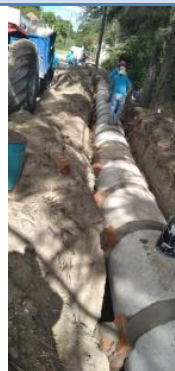
Fotografía 4: Construcción drenaje pluvial 3era calle entre 12 y 13 Av. Barrio Hacienda la Virgen
