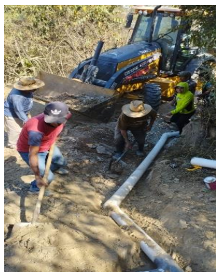
Fotografía 1: Ampliación de sistema de alcantarillado sanitario en Barrio Alcantarilla.
