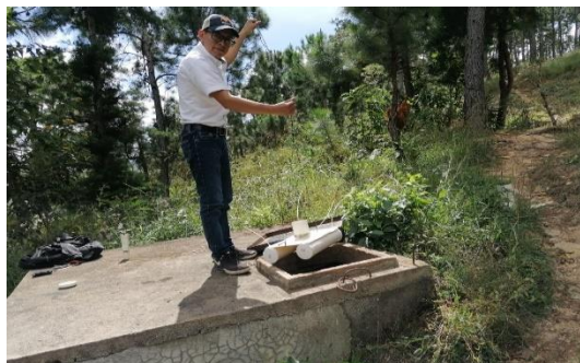
Fotografía 3: Instalación de clorador flotante en Caserío la Ceiba.
