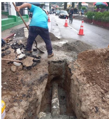
Fotografía 1: Reparación de fuga en tubería central en Barrio El Centro
