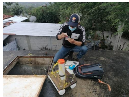
Fotografía 4: Entrega, instalación y monitoreo de cloro residual Aldea el Estoraque.
